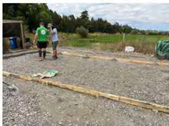
Fig. 5 Construcción de radier
