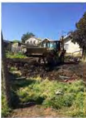
Nivelación de terreno para instalación de medio agua de emergencia, Hualañé.
