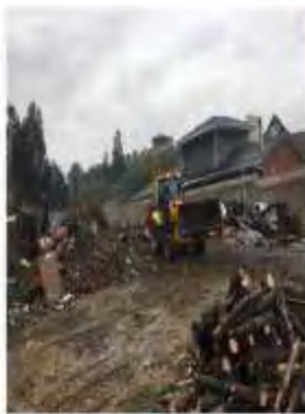
Limpieza y despeje de terreno por incendio estructural, Hualañé.
