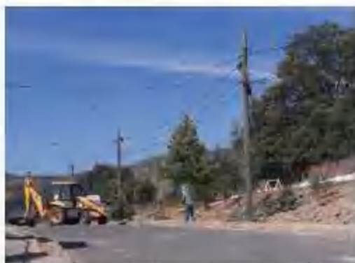
Fig. Colaboración municipal con máquina retro en preparación de terreno
