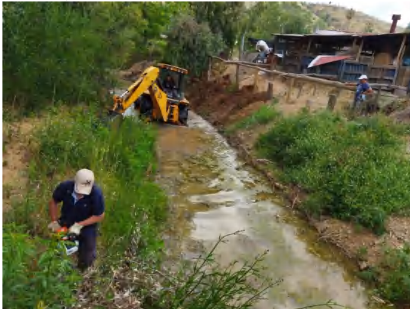
Fig. 22 Limpieza y desmalezamiento Estero Los Coipos
