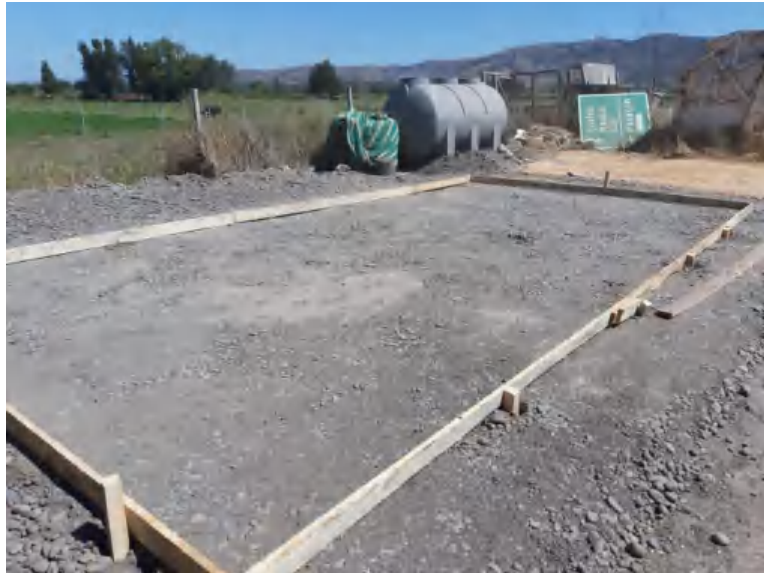
Fig. 8 Construcción nuevo Punto Limpio en diciembre 2021, ubicado en zona de estacionamiento municipal
