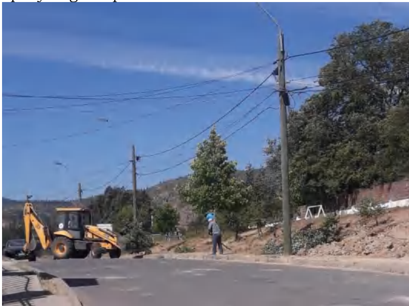
Fig. 18 Colaboración municipal con máquina retro en preparación de terreno
