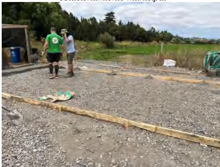
Fig. 9 Construcción de radier
