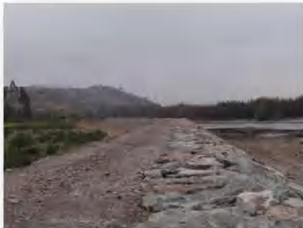
Conservación defensas fluviales sector El Porvenir $ 391.832.984
